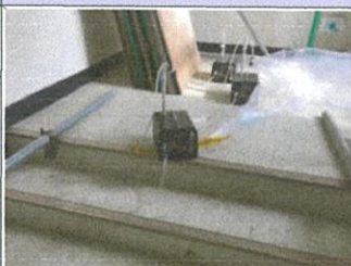
31. 음압기배출구15 (3층 1구역) (동춘관)
