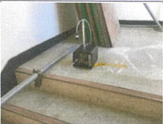
34. 음압기배출구18 (3층 1구역) (동춘관)
