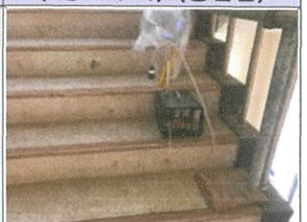
36. 음압기배출구20 (3층 1구역) (동춘관)
