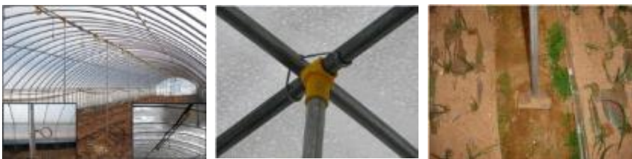
<보강지주 설치 전경> <도리와 보강지주의 연결> <바닥 지지판>
