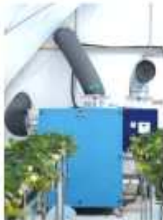
<열 회수형 환기장치 설치 모습 및 내부 입체도>
