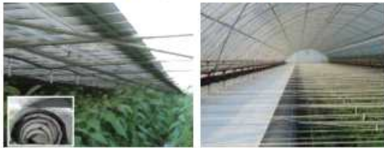
<수평권취식 다겹보온커튼 온실 내 설치 모습>
