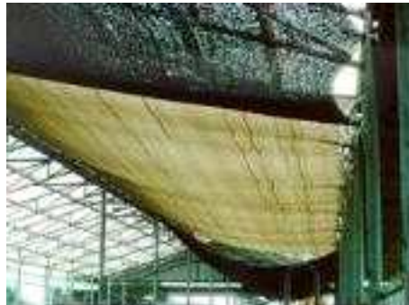
<축사지붕 및 축사내에 차광망 설치>
