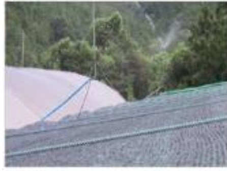
<축사 지붕 위로의 물 분사>
