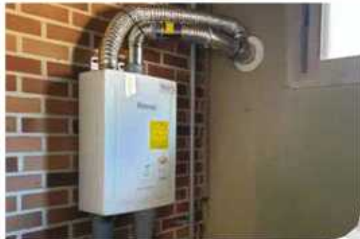
| LPG 보일러 설치 |
