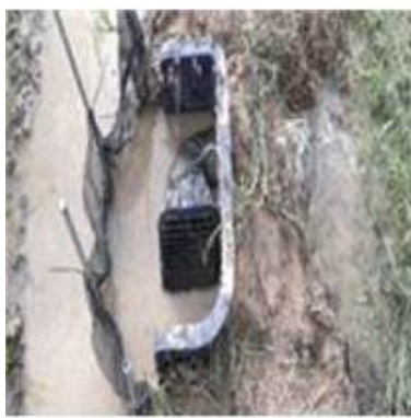
배수로 개량물꼬 및 차단망 설치
