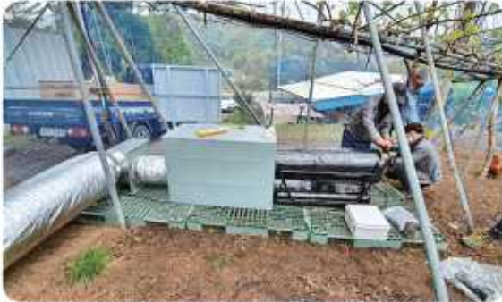
〈열풍 송풍시스템 설치 모습〉
