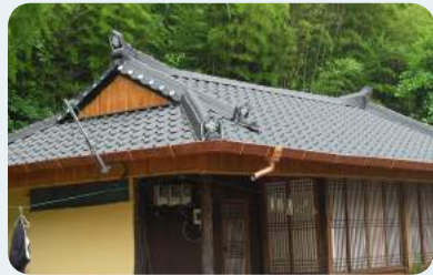
슬레이트 철거·지붕 개량 후
